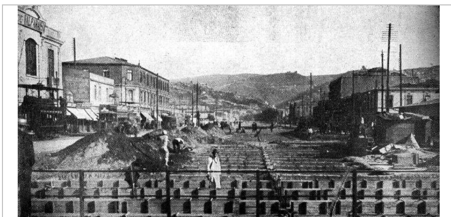
AVENIDA ARGENTINA 1913 , Cauce del Estero de las "Delicias". Comienzo del abovedamiento en el tramo Quillota-Pedro Montt.
